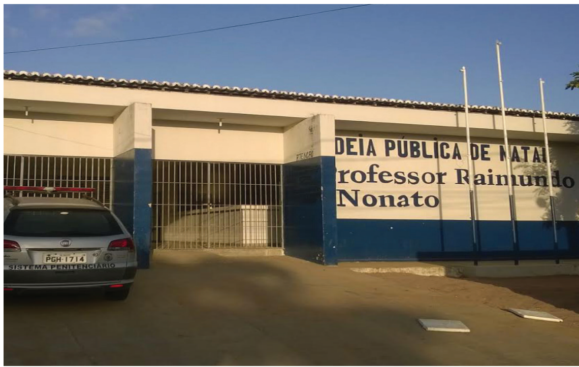
A Sejuc RN está investindo na melhoria do Sistema Prisional do RN com ações como a reforma de unidades prisionais no interior de todo o Estado
